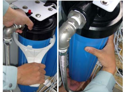
3. フィルター缶内の水を捨てて新しいフィルターに交換して下さい。
