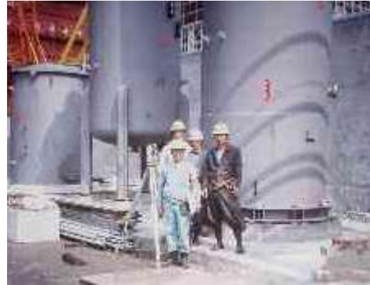
発電所へ設置の例 カチオン/アニオン塔等
