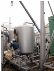
④先ずろ材を 抜き取ります
